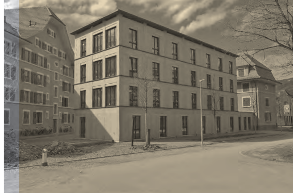
Neues Holzgebäude an der Wasenstrasse mit Betagtenpflegeverein im Parterre und Familienwohnungen darüber / Construction en bois, avec au rez-de-chaussée le home du BPV et au-dessus des appartements
