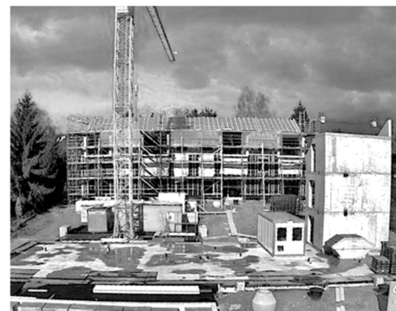
Das Gebäude Nord ist erfolgreich aufgerichtet und bereit für den Innenausbau
