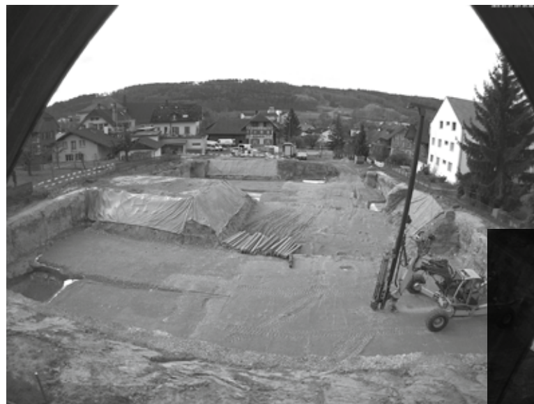
Stützpfähle einschlagen / Mise en place des pilotis de soutien
