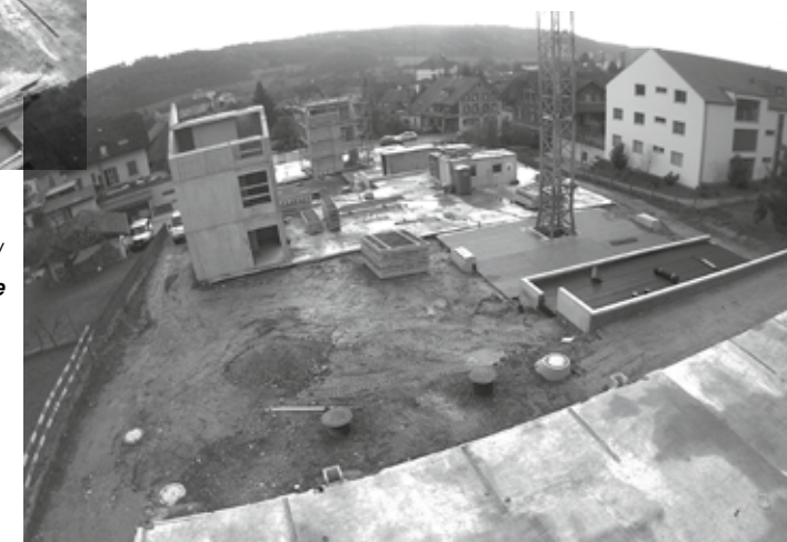
Fertigstellung der Betonierarbeiten / Achèvement de bétonnage
