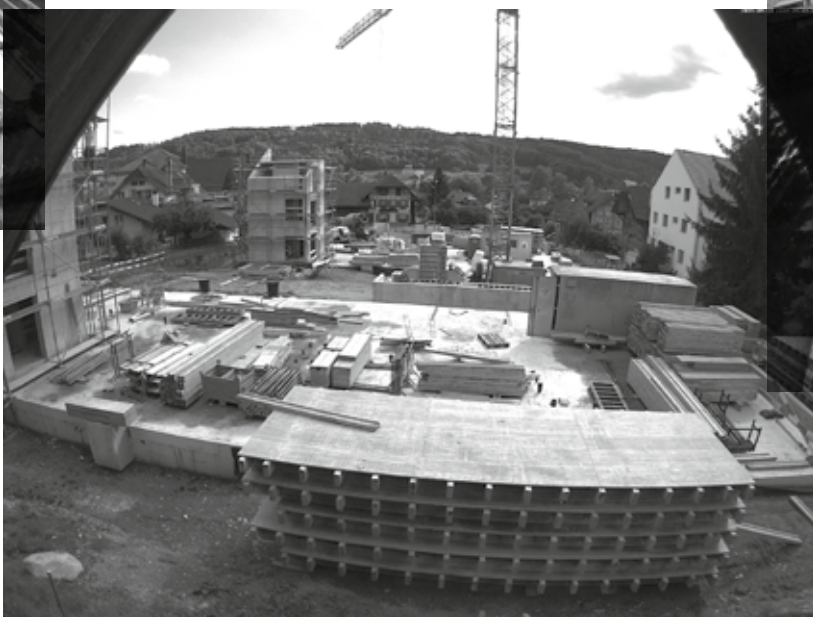
Lift und Treppenhäuser entstehen / Construction des cages d'escaliers et d'ascenseurs
