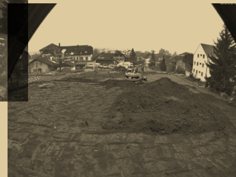
Der Humus wird abgetragen / L'humus va être éliminer
