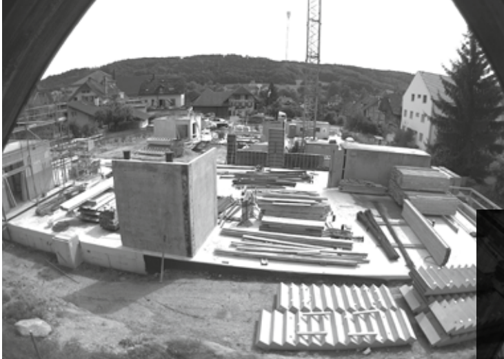
Lift und Treppenhäuser entstehen / Construction des cages d'escaliers et d'ascenseurs
