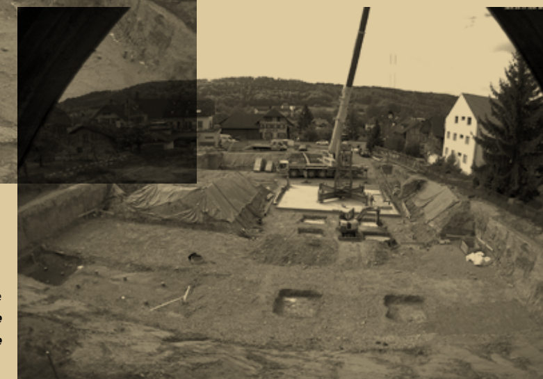
Aufbau Kran mit Auslegearm über die ganze Baustelle / Montage de la grue fixe par une grue mobile
