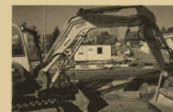
Wenige Tage nach dem Spatenstich: Der Kanalisationsanschluss wird erstellt.
