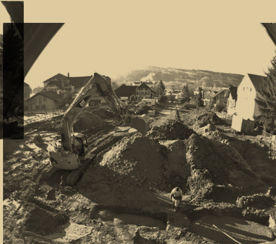
Sicherheitsfundamente gegossen. Start Grubenbau / Début du terrassement et déblaiement de la terre
