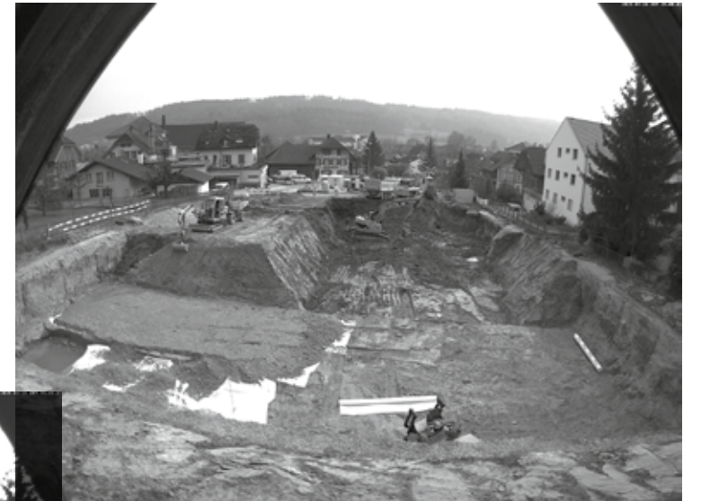
Bereich Keller sichtbar / La zone du sous-sol apparaît
