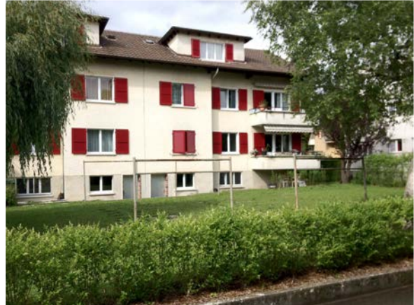
Photo: 2 bâtiments en bonne état
