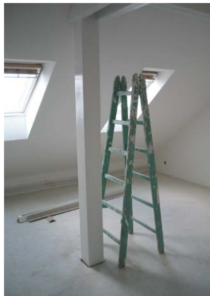
Bild: Assainissement Sonnhalde
