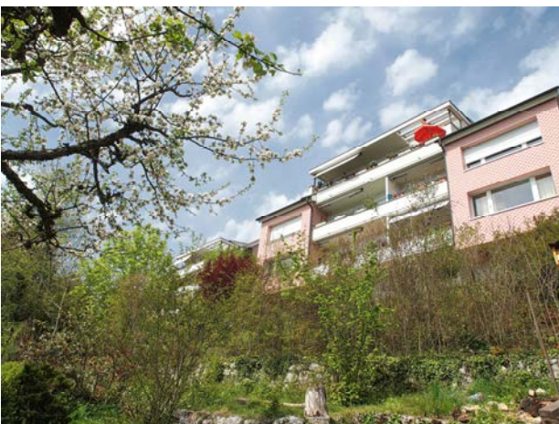
Photo: Situation la meilleure vue sur les Alpes, Falbringen
