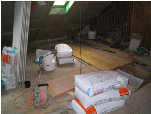
Photo: Assainissement en détail
